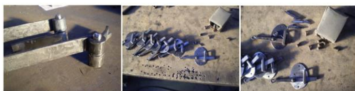
Logis Saint-Gaubert de Celles-sur-Belle, restauration et création d'éléments serrurerie portes et fenêtres
